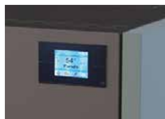
Grafic LCD Touch en color de 3.5" para programación y gestión de la caldera.
